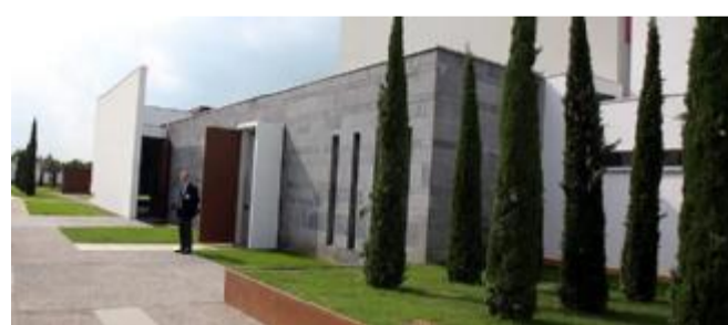
L'ingresso del tempio crematorio. Ultimati i lavori di riqualificazione
